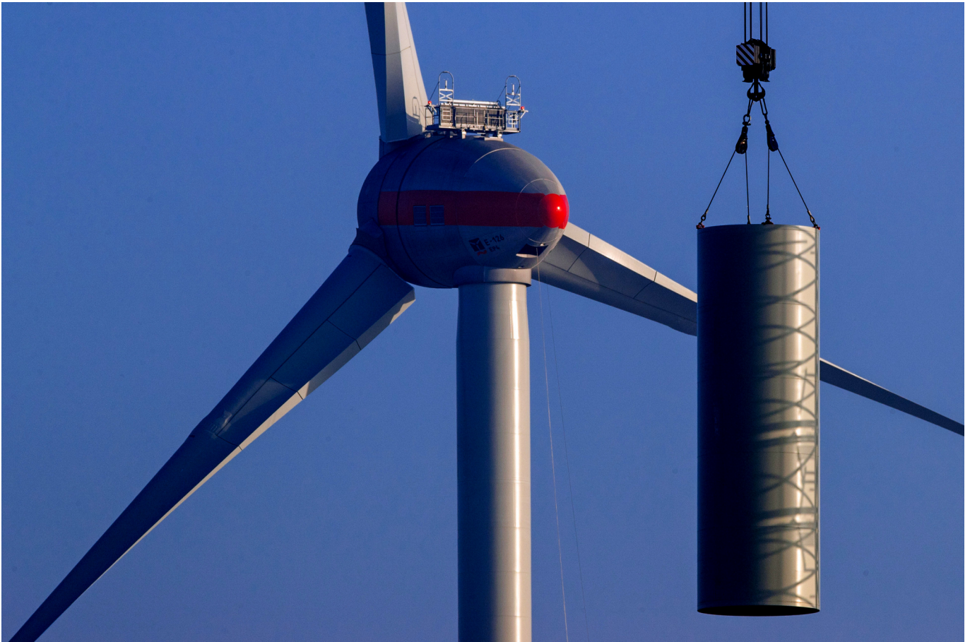
Noch wird hier aufgebaut: ein Windrad bei Tribsees in Mecklenburg-Vorpommern. (Foto: picture alliance / Jens Büttner/)
